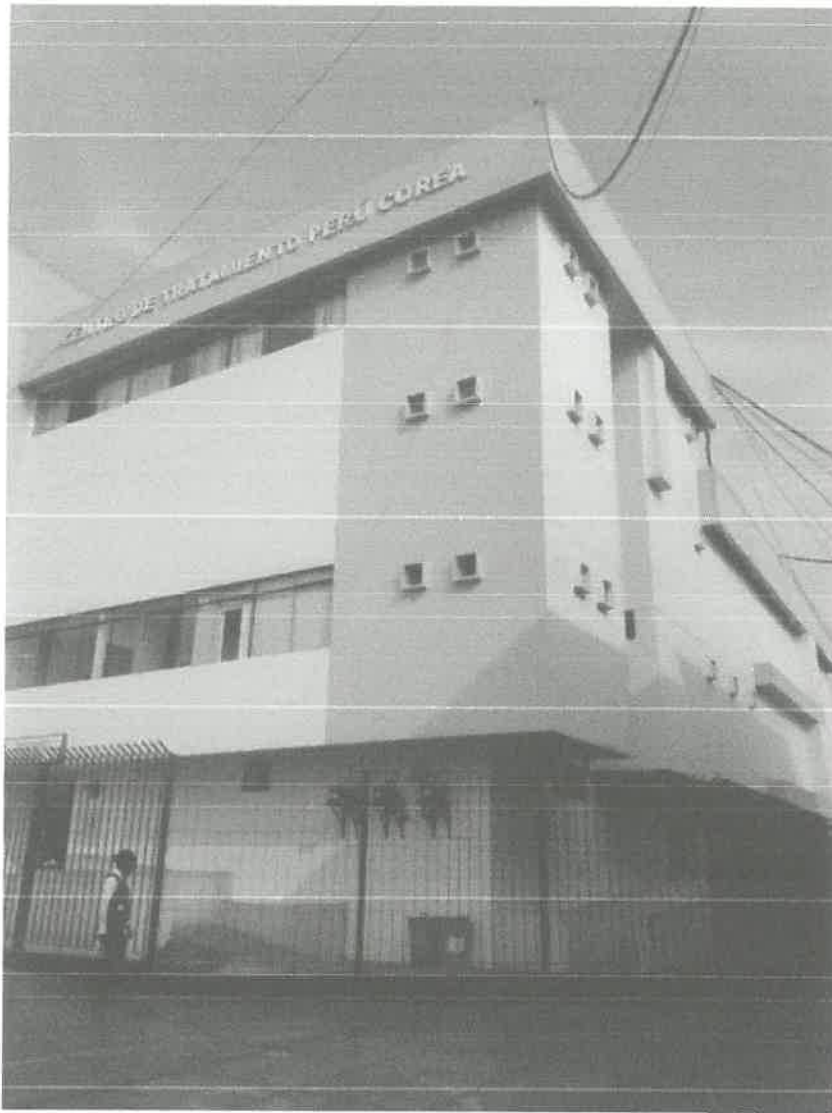
EDIFICIO CETIDE DONDE SE ENCUENTRAN ALGUNOS AMBIENTES DEL DCTCV Elaboración Propia
