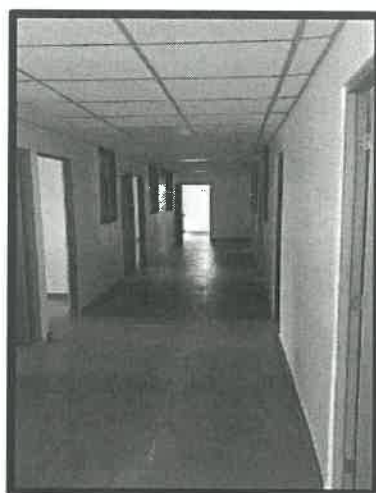
Zona de Oncología Pediátrica 2do. Piso
